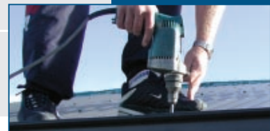
EDGE OF SHEETING
